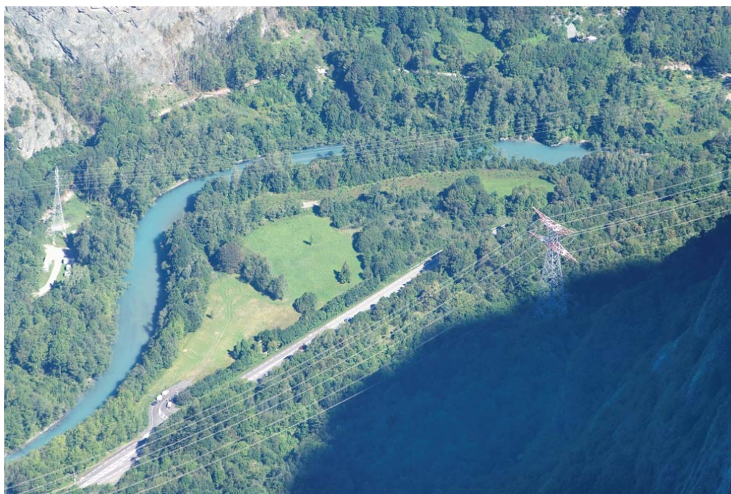
La Romanche (Isère) – Site de construction du futur barrage-prise d'eau - EDF © Médiathèque – CHRISTOPHE HURET
