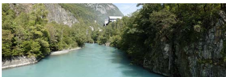
La Romanche à Gavet (Isère) - Site de construction de l'accès à la future centrale (pont et plate-forme en rive droite) EDF © Médiathèque – CHRISTOPHE HURET
