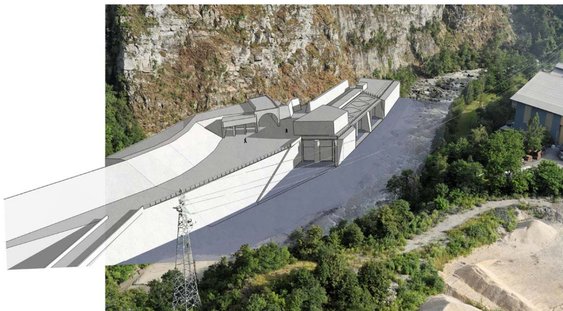
EDF © – DOMINO EUROL – Plate-forme d'accès sur la berge en rive droite
